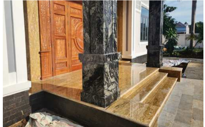
Công trình: Biệt Thự Anh Khoa Cam Lâm- Tp Nha Trang - Khánh Hòa
