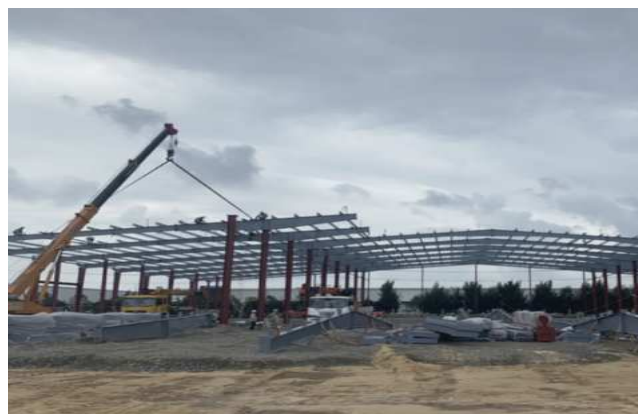
Công trình: Nhà xưởng A. Lê Quang KCN Ninh Thủy - Khánh Hòa
