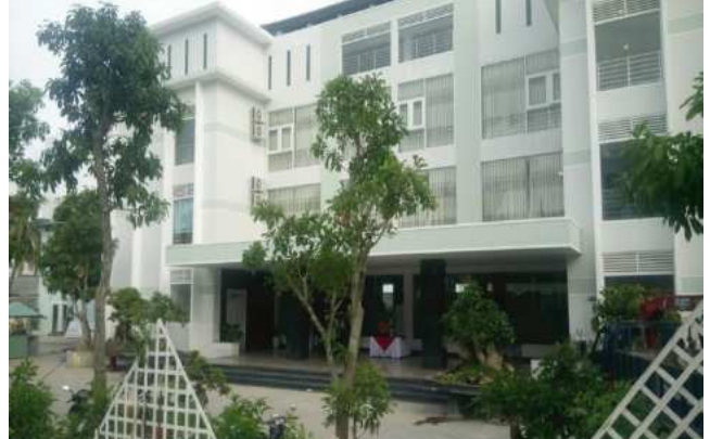
Công trình: Khách Sạn Vạn Anh (D' Qua) -Nha Trang - Khánh Hòa
