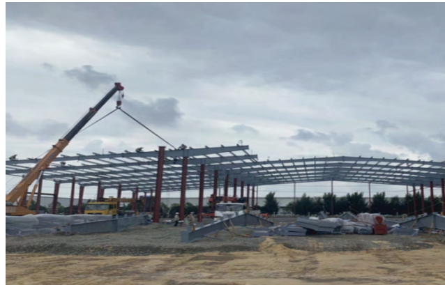
Công trình: Nhà xưởng A. Lê Quang KCN Ninh Thủy - Khánh Hoà
