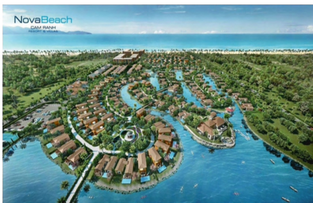
Công trình: Resort Nova Beach Mỹ Mỹ - Cam Ranh - Khánh Hòa
