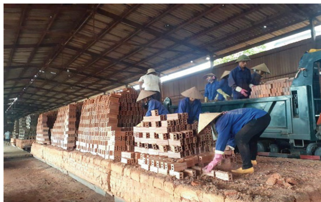
Công trình: Nhà máy Gạch Tuynel Thu Hà Ninh Xuân - Ninh Hòa - Khánh Hòa
