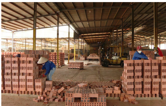
Công trình: Nhà máy Gạch Tuynel Khánh Thành - Ninh Xuân - Ninh Hòa - Khánh Hòa
